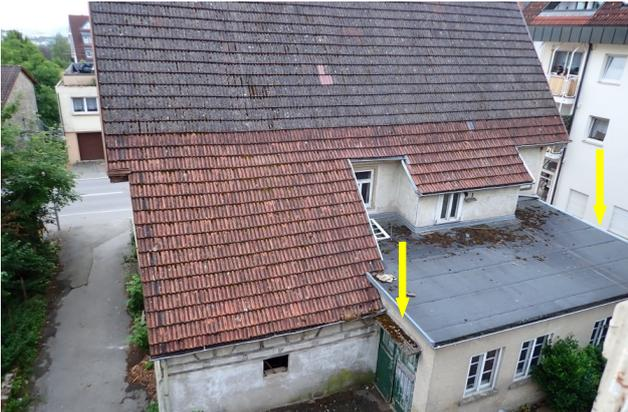
Abb. 22: Blick auf das Dach von Gebäude 13 einschließlich des Anbaus mit seitlichen Attika-Blechen (gelbe Pfeile).
